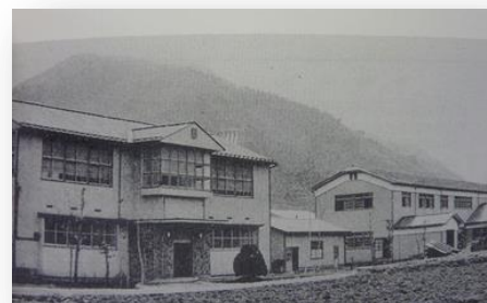
新校舎完成（後ろは水槽山）
