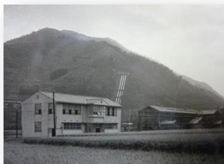
建設中の校舎（田んぼの中に）
