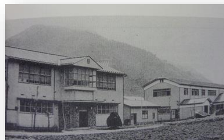
新校舎完成（後ろは水槽山）
