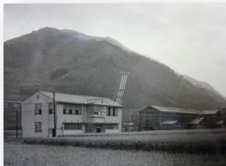
建設中の校舎（田んぼの中に）
